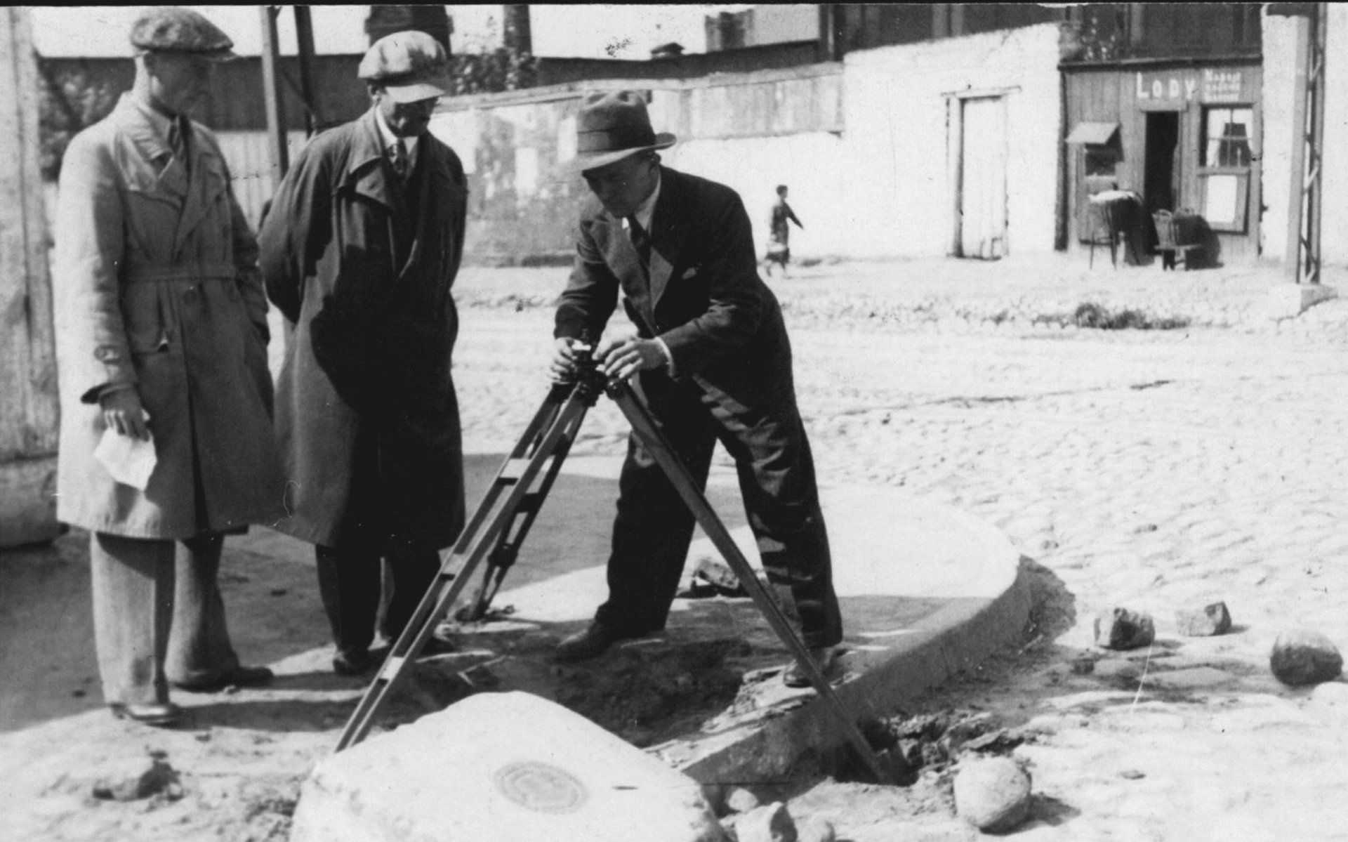
Skrzyżowanie ulic Pomorskiej i Zagajnikowej - ustawianie statywu nad punktem bazowym „Bn”.
