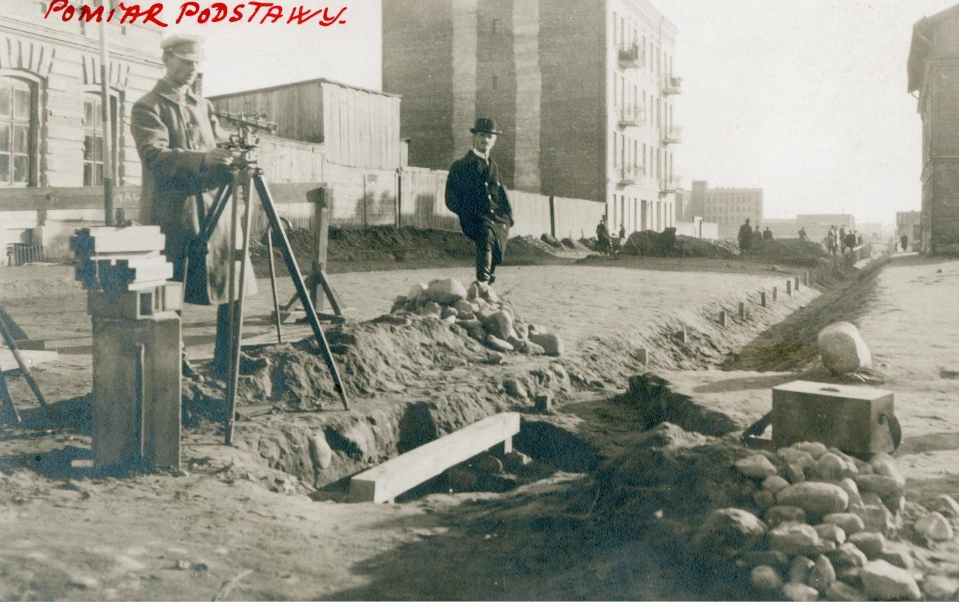
Pomiar długości bazy w ul. Zagajnikowej (Kopcińskiego) w dniu 7 XI 1918 r. Obok teodolitu ustawionego prostopadle do osi bazy przy punkcie „Bn” stoi Wacław Bobrowski, dalej Włodzimierz Jastrzębski.
