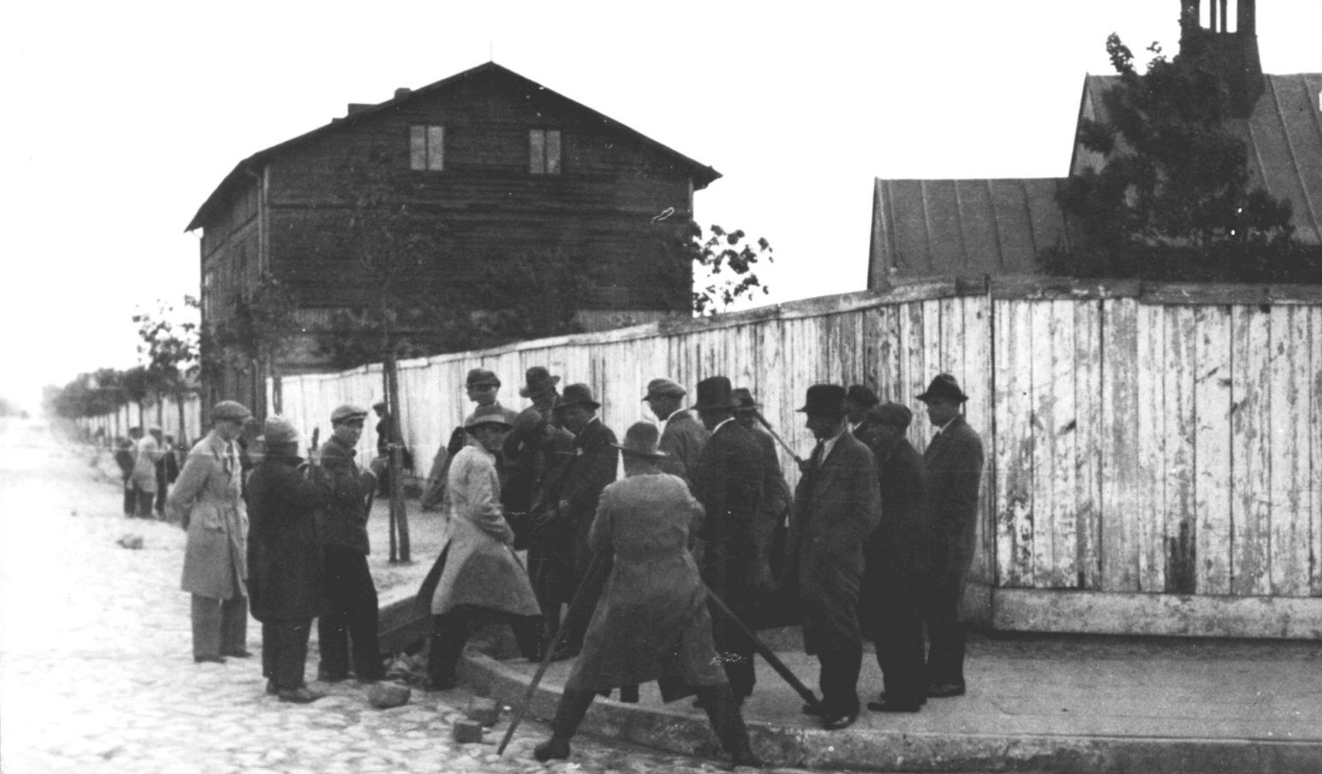
Rozpoczęcie pomiaru bazy drutami inwarowymi. W głębi po prawej drewniany kościół pw. Św. Teresy.
