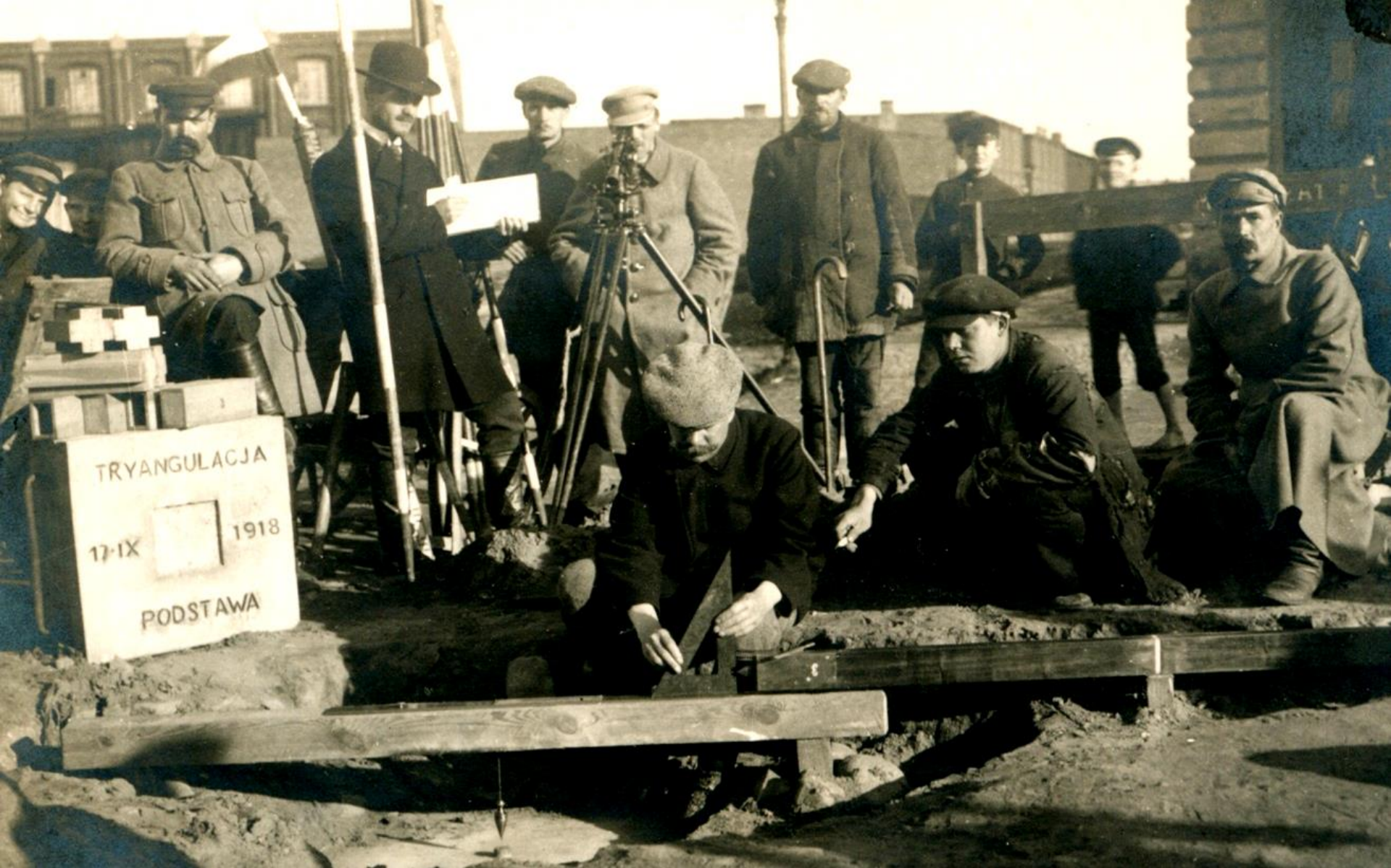
Ostatnie czynności przy pomiarze bazy w dniu 7 XI 1918 r. na punkcie „Bn”. Obserwacje prowadzi inż. Bobrowski, po lewej (w kapeluszu) z dziennikiem w ręku - technik Jastrzębski. Doskonale widoczna betonowa pokrywa znaku z napisem: TRYANGULACJA - 17 IX 1918 – PODSTAWA.
