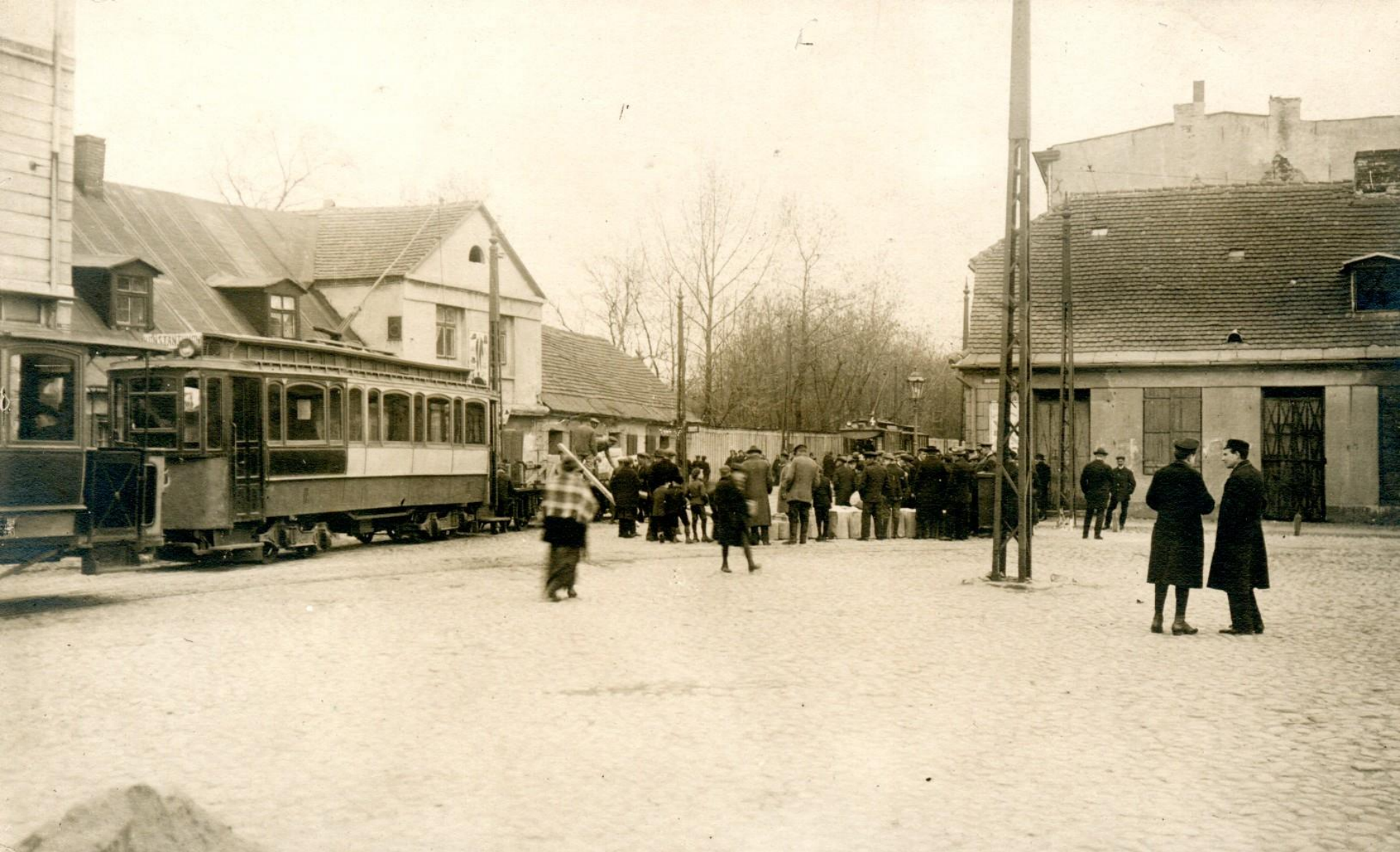
Wyładunek betonowych znaków geodezyjnych z platformy tramwajowej na Górnym Rynku (pl. Reymonta) w 1920 r.
