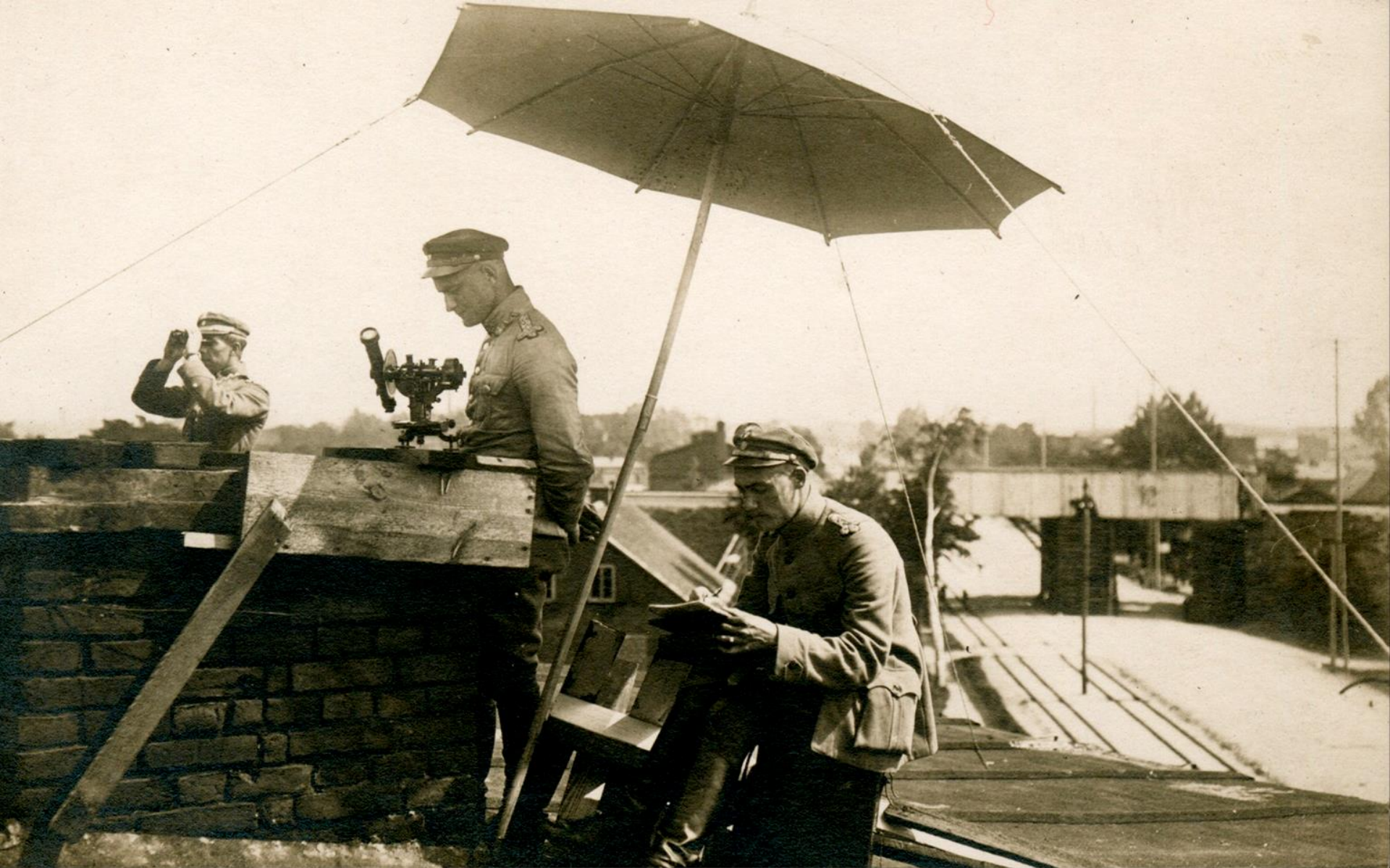
Oficerowie z kursów mierniczych na punkcie „Ps”, usytuowanym na dachu domu przy ul. Pabianickiej, za wiaduktem kolejowym.
