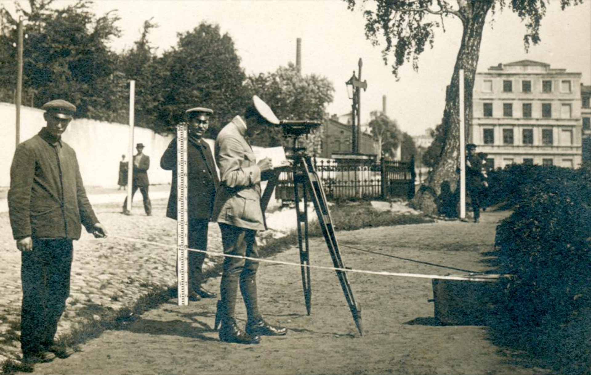
Niwelacja precyzyjna m. Łodzi, wykonywana w lecie 1919 r. Widoczny niwelator firmy Bamberg z lunetą o długości 45 cm oraz łąty rewersyjne firm Bamberg i Gerlach, używane do pomiarów, o długości 3 m i 1.5 m.
